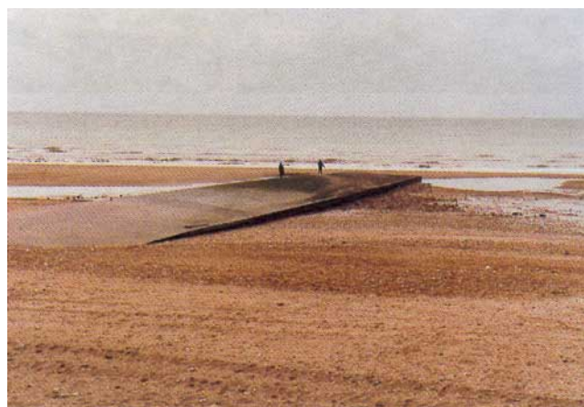
Figure 22 – Épi à sable en maçonnerie. Villers-sur-Mer (Calvados)
