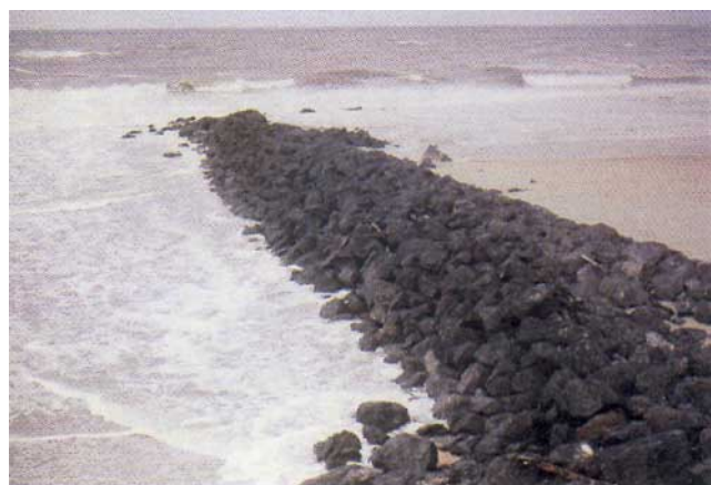
Figure 21 – Épi en enrochements naturels. Plage de Capbreton
