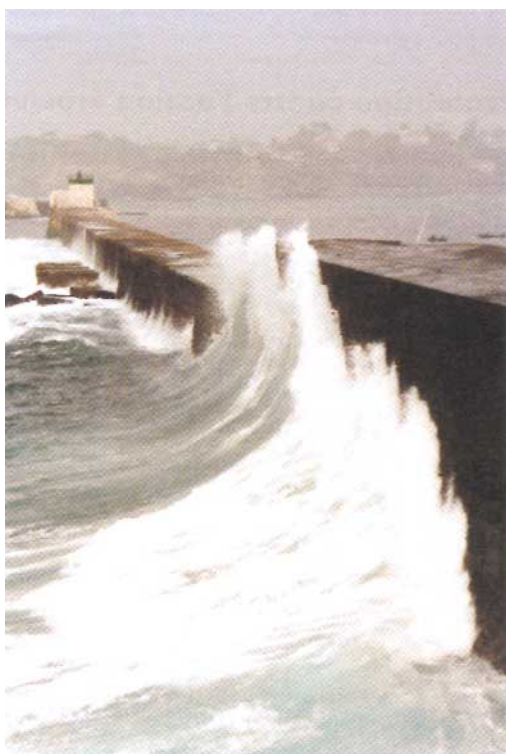
Figure 14 - Digue de Socoa - Saint-Jean-de-Luz. Mise en vitesse des lames sur un parement arrondi
